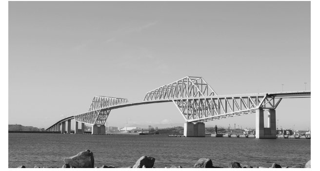
東京ゲートブリッジ
